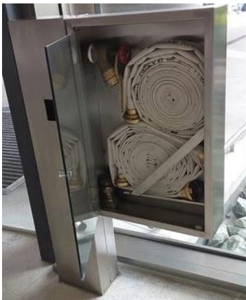
Figura 6 Exemplo de caixa de hidrante
